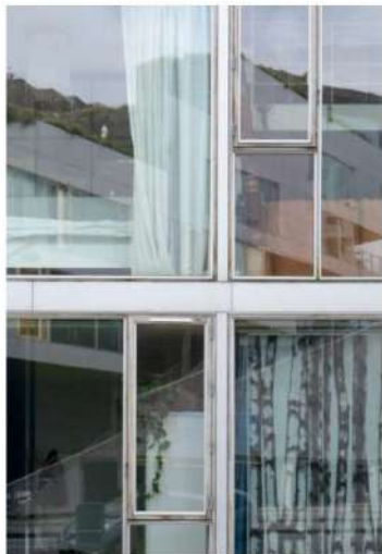
Dokumentieren von Reuse- Prozessen für das Circular Construction
